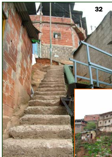
Figura 32. Las Construcciones de nuevos pisos en los techos de las casas no cesan en la zona.
