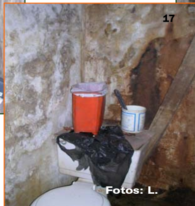
Figura 16. Las filtraciones abarcan columnas y paredes en los hogares, tanto en la parte baja como en la parte media.
