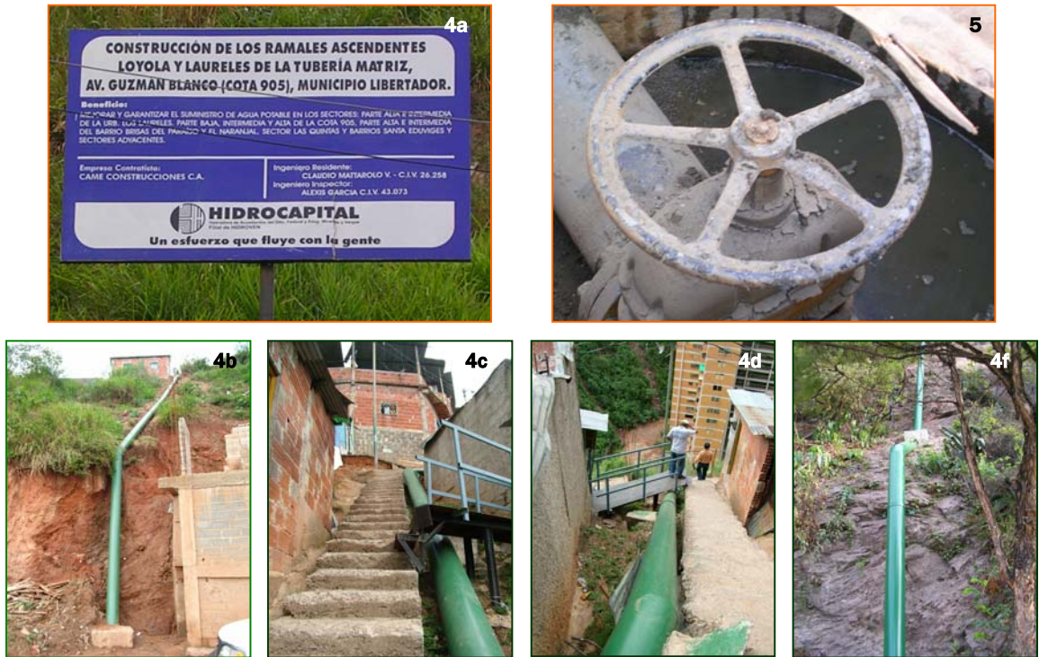
Figura 4 (a-f) : Valla de construcción de los ramales ascendentes (Loyola y Laureles) y detalle del recorrido de la tubería en la Cota 905) Figura 5. Válvula del Alimentador Guzmán Blanco en la Cota 905 de Caracas-Venezuela
