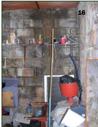
Figura 16. Las filtraciones abarcan columnas y paredes en los hogares, tanto en la parte baja como en la parte media.
