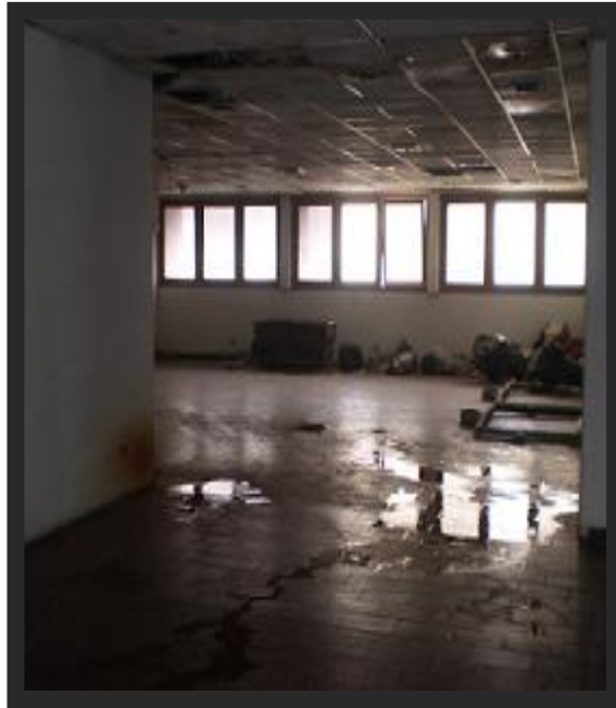
Panel de Control (antes)
