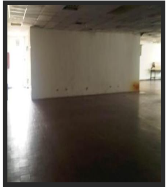
Área de Cocimiento (después)
