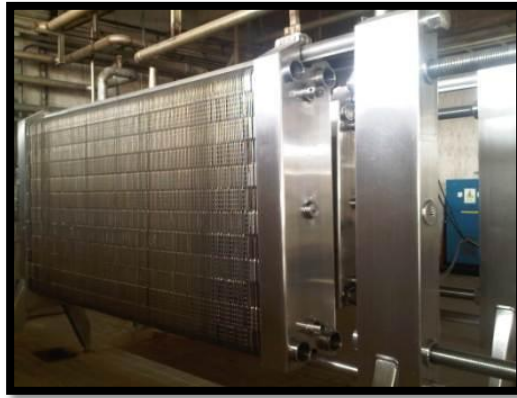
Figura 5. Vista lateral del Intercambiador de Placas. Fuente: Nuñez y Torrealba (2012).
