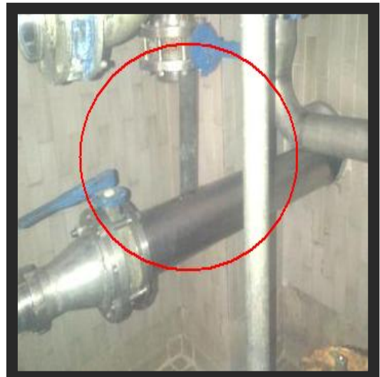
Línea de ajuste de malta a la línea de mosto (después)
