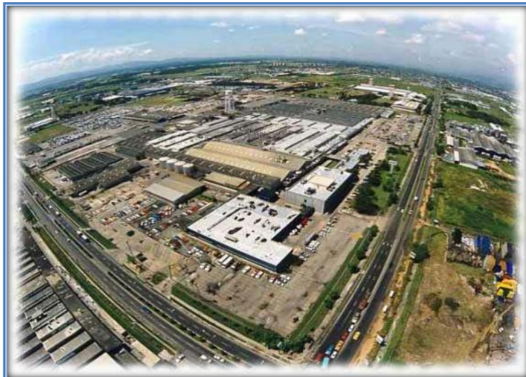
Figura 1. Vista aérea de la planta Fuente: Imagen suministrada por la empresa.
