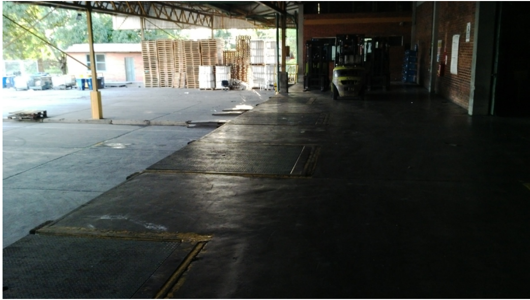
Figura Nro.7: Plataforma de Carga.
