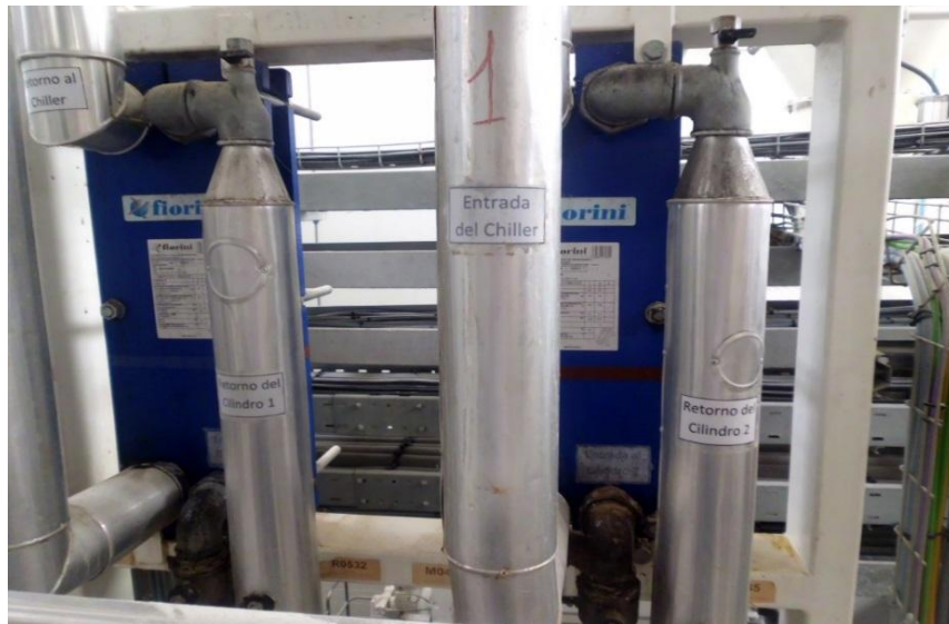
Anexo 18 (Identificación tuberías superiores agua Fria)
