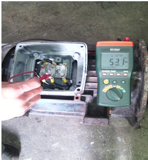
Figura N° 3 (Pruebas de funcionamiento)
