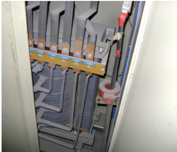
Figura 6. Bobinas del Panel de control de la línea 3 de colada de alambrón
